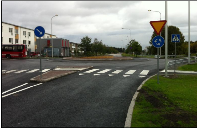
Bild 6: Cirkulationsplats med ej överkörningsbar rondell
