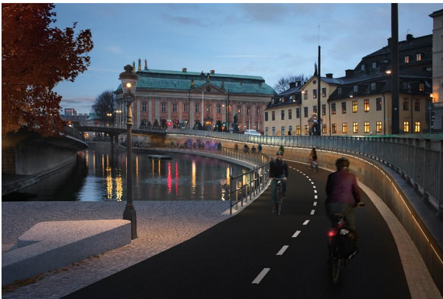
Bild 15. Visionsbild, vy norrut mot Riddarholmskanalen och Riddarhuset. Belysning i murkrön, komplettering med punktbelysning i befintliga belysningsstolpar på Munkbron, gatlykta (av samma typ som längs med Riddarhuset) och effektbelysning under Riddarholmsbron och i valven.
