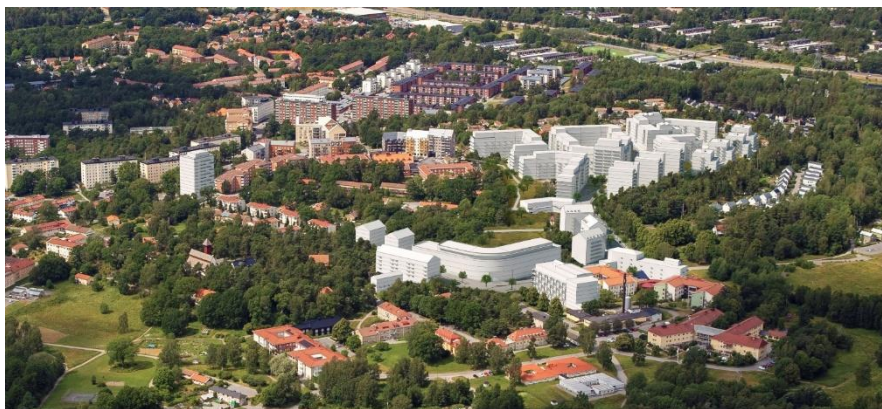
Flygvy över planområdet med omgivning. Ny bebyggelse i vitt. Bild: Tengbom
