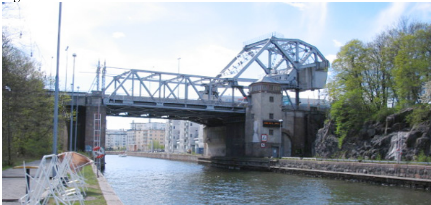
Bild 1. Befintlig bro/utseende efter Totalrenoverad bro.
