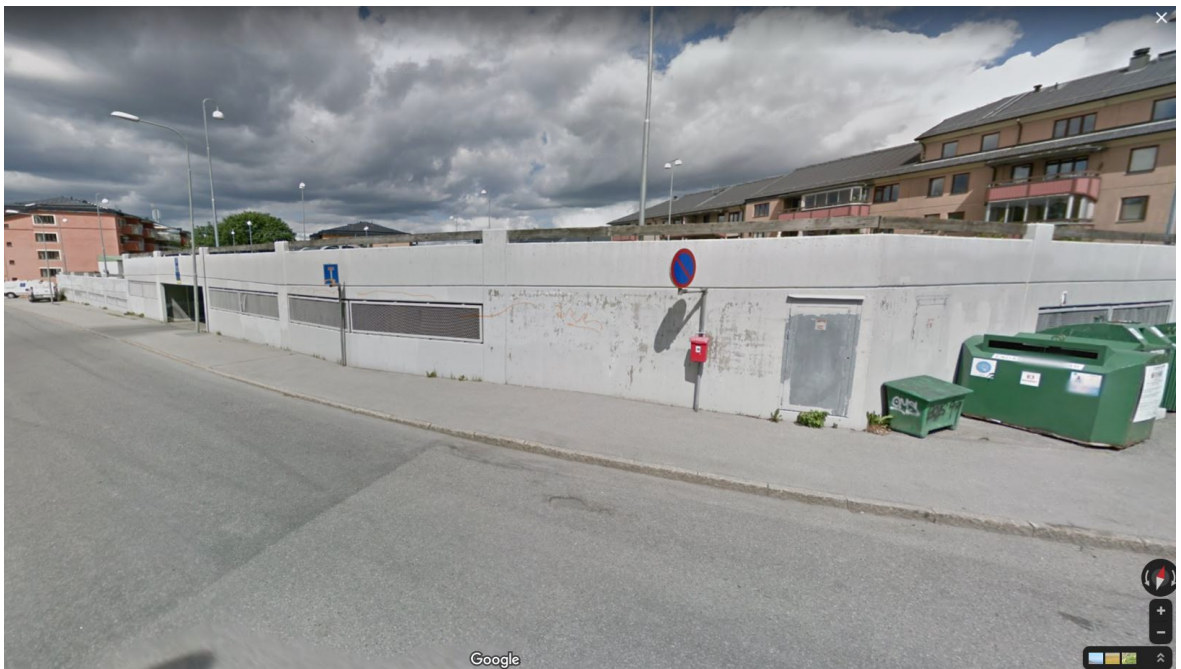
Bild 5. Gatuvy från Åstorpsringen befintlig situation.
