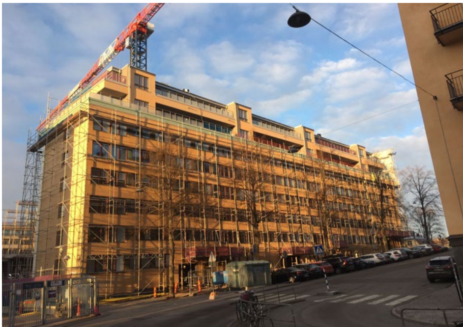
Bild 2. Påbyggnad i två våningar. Etapp 1 av påbyggnaden motsvarande 25 lägenheter.
