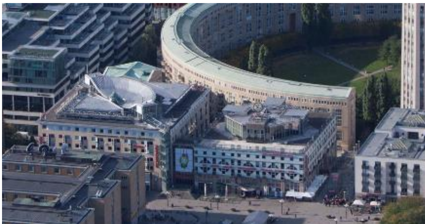
Söderhallarna med Björkhallen, Tjärhovsgränd och Saluhallen. Flygfoto över platsen sett från öster (SBK/Lennart Johansson).
