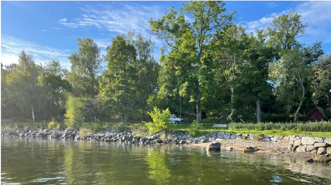
Figur 10. Merparten av stränderna är utfyllda och erosionsskydd har anlagts för att stå emot erosionen från vågorna.
