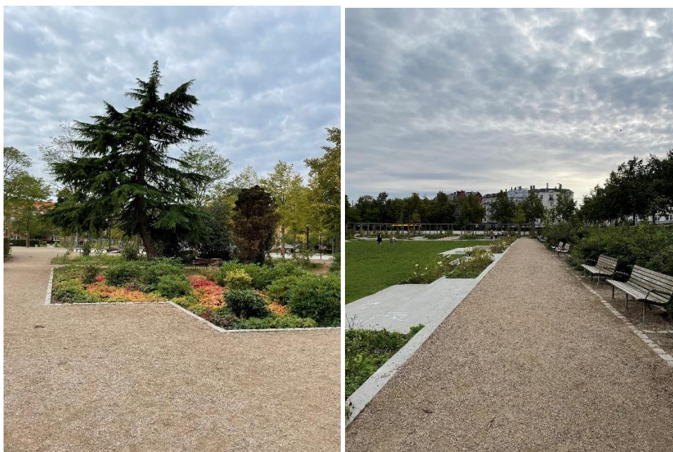
Bild 3 och 4. Bilder på infiltration i växtbädd och nedsänkt gräsmatta i Enghavepark i Danmark. På bilden syns även grus vilket är en genomsläpplig beläggning. Foto: Josefin Jansson, 2022
