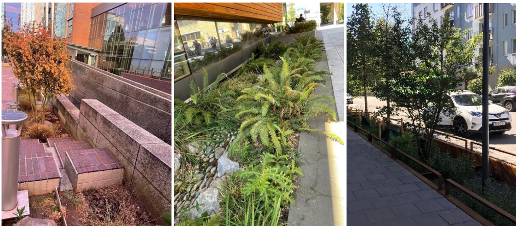
Bild 5, 6 och 7. Bilder på nedsänkta växtbäddar i Portland (5 och 6) och Norra Djurgårdsstaden (7). Foto från Portland av Sophie Jutterström, 2022
