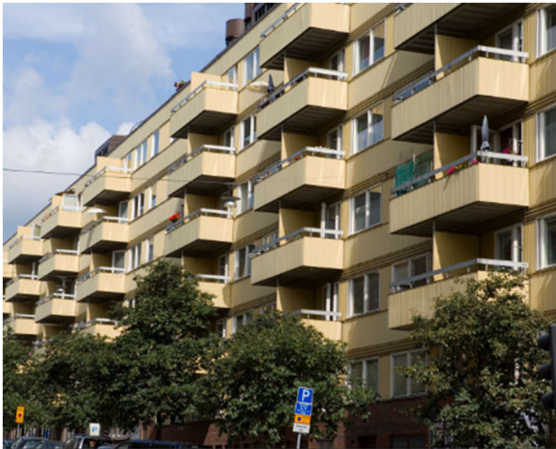
Bild 2: Fastigheten Trossen 13 bestående av vård- och omsorgsboendet Alströmerhemmet och servicehuset Fridhemmet.
