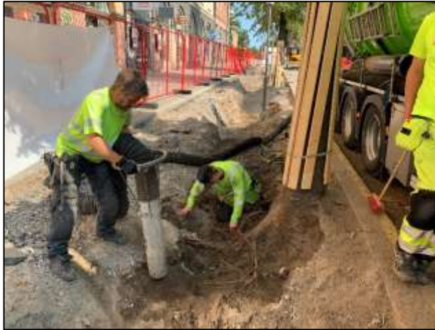
Figur 14, Exempel på växtbäddsrenovering av befintligt träd med vakuumschakt
