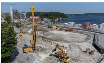
Markrening i Ropsten och Kolkajen
