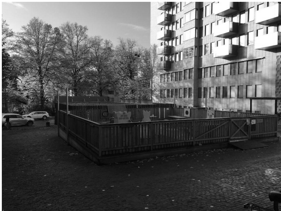
Förskolegården är placerad mitt i kvartersgården. Den har en plan yta och är inhägnad med ett staket i trä. Den nås genom en mindre ramp.
