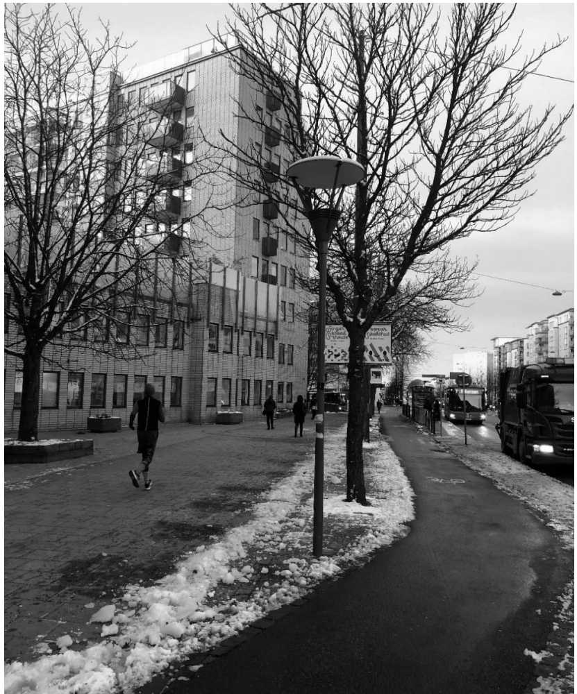
Fastigheten Hemmet 18 vid Drottningholmsvägen. I förgrunden ses lågdelen som sammanbinder de två högre skivhusen.
