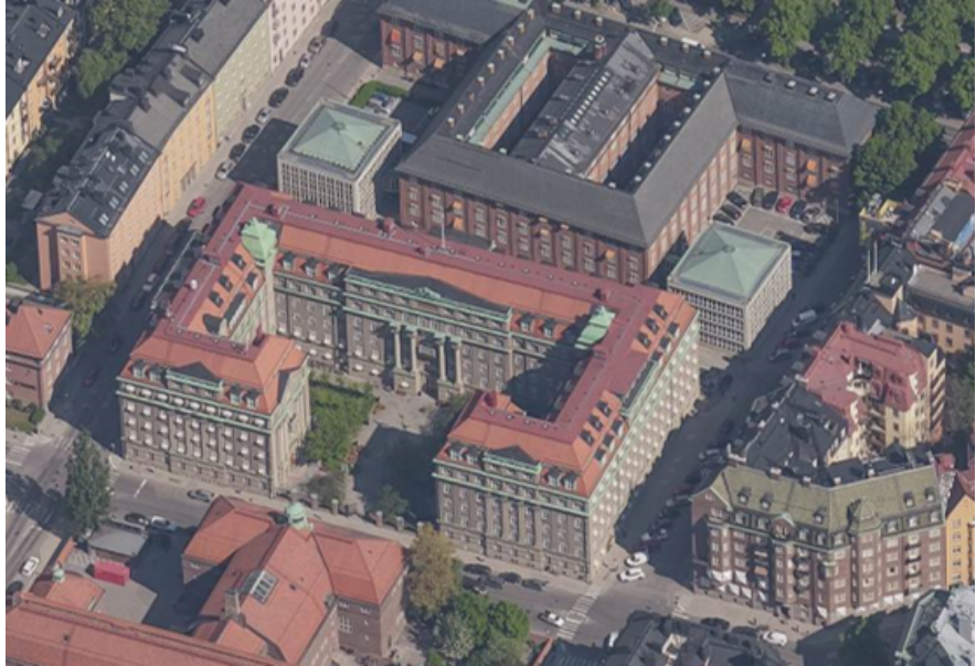
Flygvy över planområdet med fastigheten Uppfinnaren 2 och dess U-formade byggnadsvolym i centrum. (Stockholms stad)
