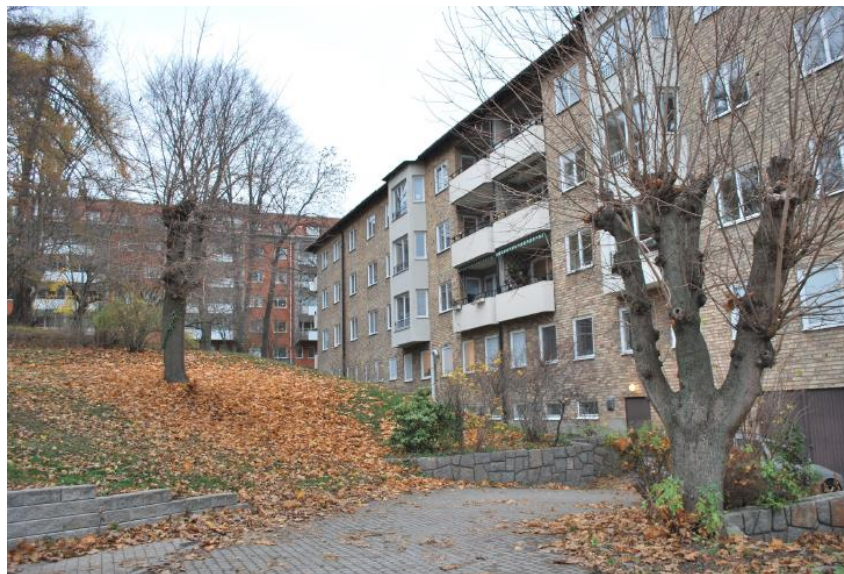
Befintlig byggnad sedd från bostadsgården.
