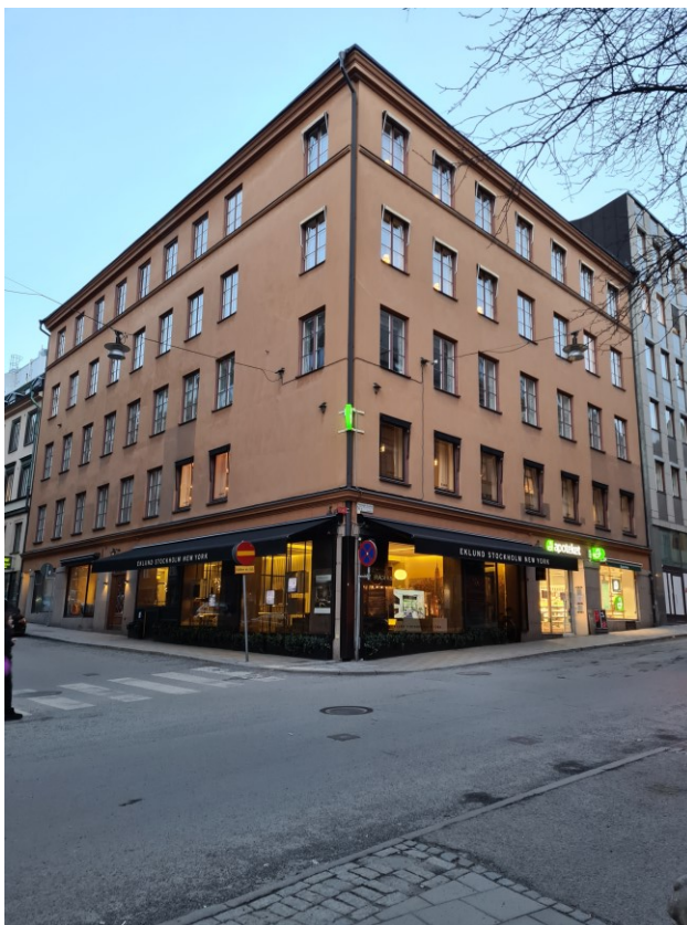
Befintlig byggnad i hörnan Grev Turegatan/Humlegårdsgatan. Foto: Ebba Älvgren, WSP.
