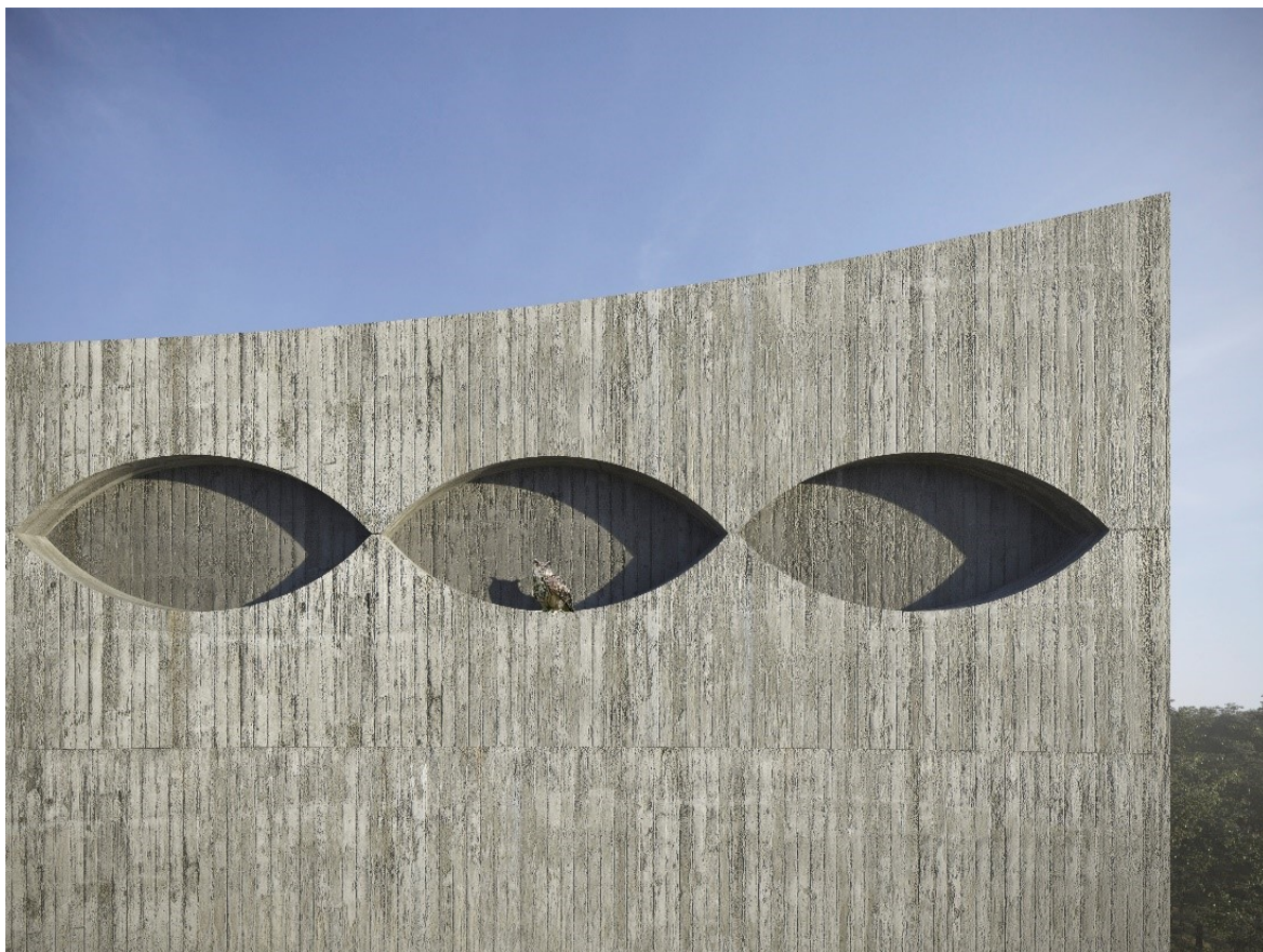
Den nya vattenreservoaren gestaltas med långsgående lansettformat mönster i djup relief. I en av dessa håligheter förberedas en häckningsplats för berguv.
