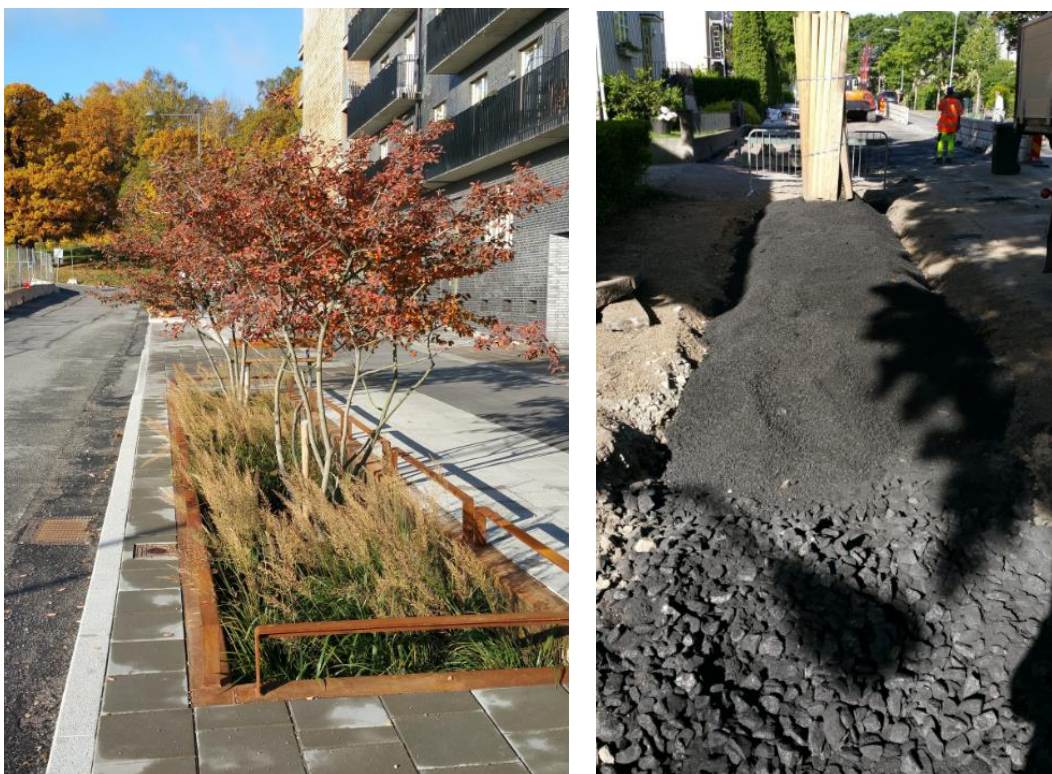
Figur 7. Exempel från en nedsänkt växtbädd från ett projekt i Norra Djurgårdsstaden och i Bromma-Nockeby. Dagvatten leds via en dagvattenbrunn med sandfång på gatan (bild på vänstra sidan). Biokol med makadamstenar som används i nedsänkta växtbäddar för att förbättra reningseffekten av dagvattnet och livslängden av växtbädden (bild på höger sida).
