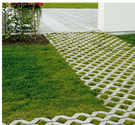
Figur 10 Markbeläggning med olika grad av öppna fogar som medger återledning av vatten till underliggande material.
