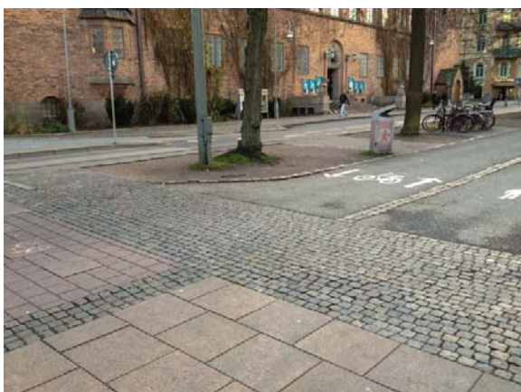
Figur 10 Markbeläggning med olika grad av öppna fogar som medger återledning av vatten till underliggande material.
