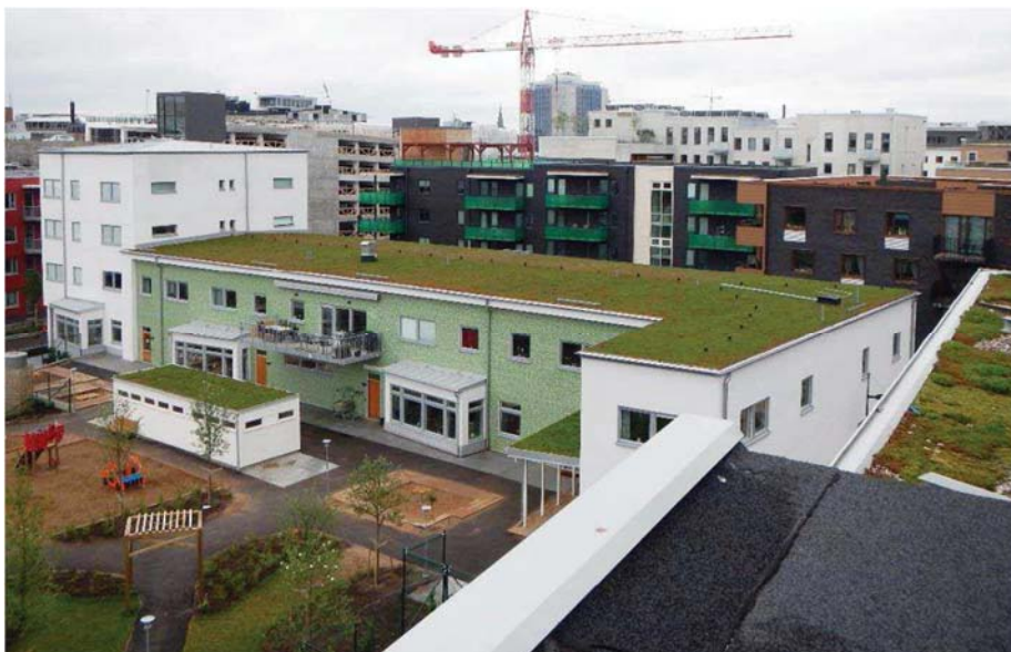
Figur 9 Exempel på extensivt tak.
