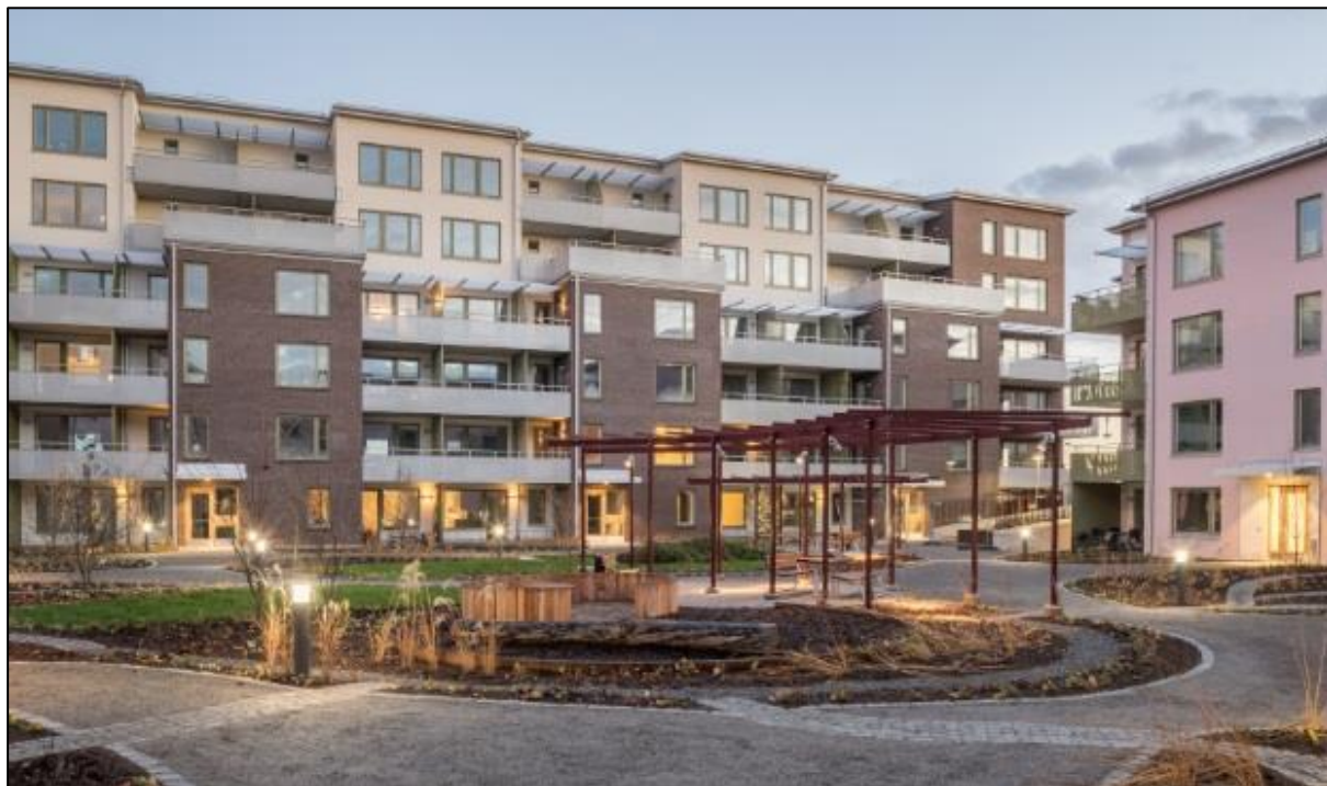
Figur 5-1. Avledning av takvatten till planteringar via rännalar anlagda i gatsten. Exempelbild från Linnéhuset i Uppsala (Källa: Uppsalahem, år).
