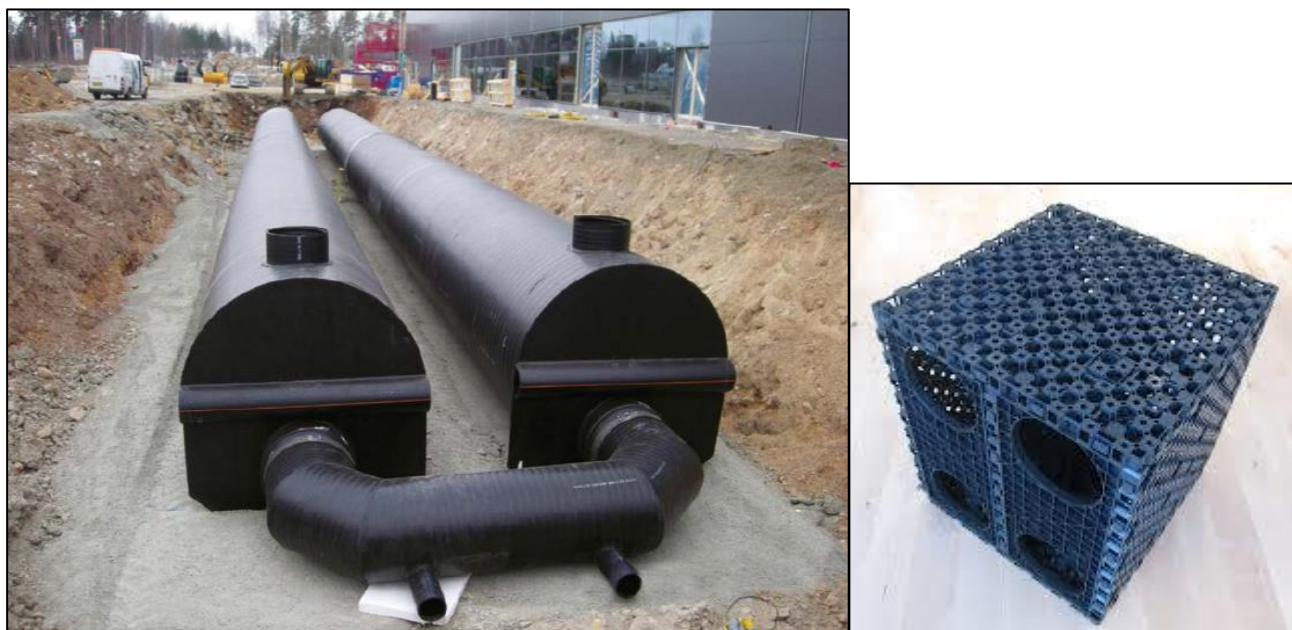
Figur 5-5. Fördröjningsmagasin i plast, i form av rörmagasin (vänster) och plastkassetter (höger).
