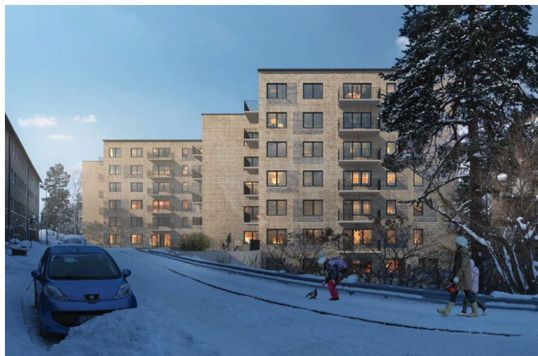
Vy mot punkthusen från Karlskronavägens övre gatunivå. I förgrunden syns det norra punkthuset. BSK Arkitekter, 2018.
