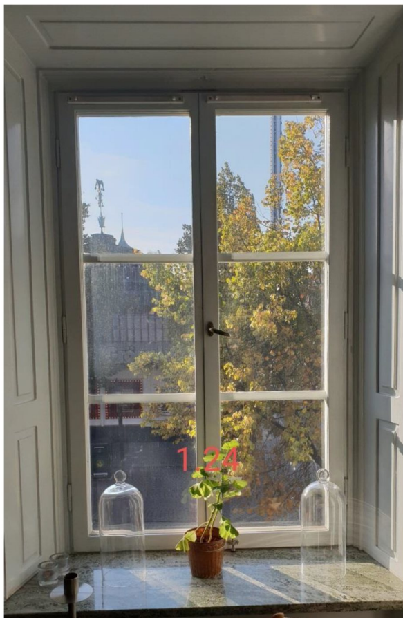
Den vanligast förekommande fönstertypen i byggnaden. Notera den utanpåliggande spröjsen, och avsaknaden av profilerings.
