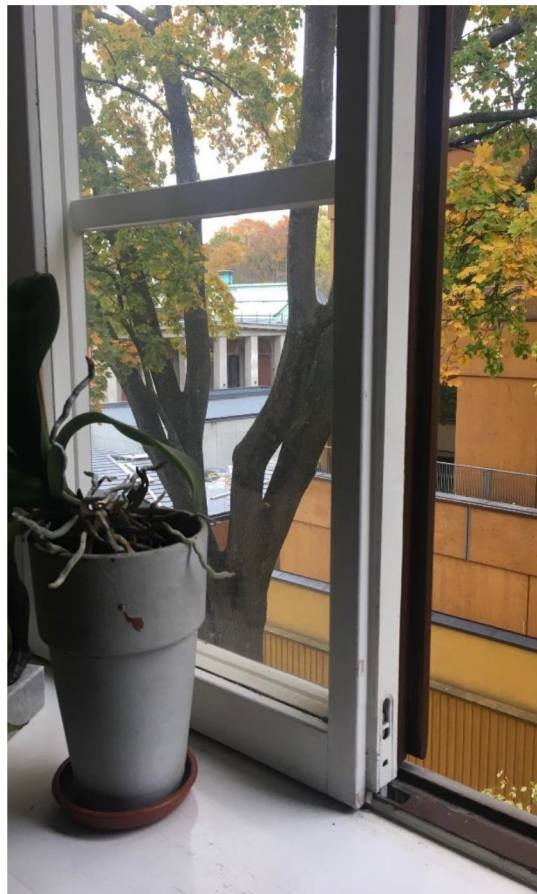
Den vanligast förekommande fönstertypen i byggnaden. Notera den utanpåliggande spröjsen, och avsaknaden av profilerings.
