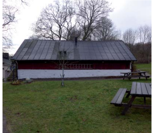
Källarbyggnaden är placerad på en terrass intill huvudbyggnaden.
