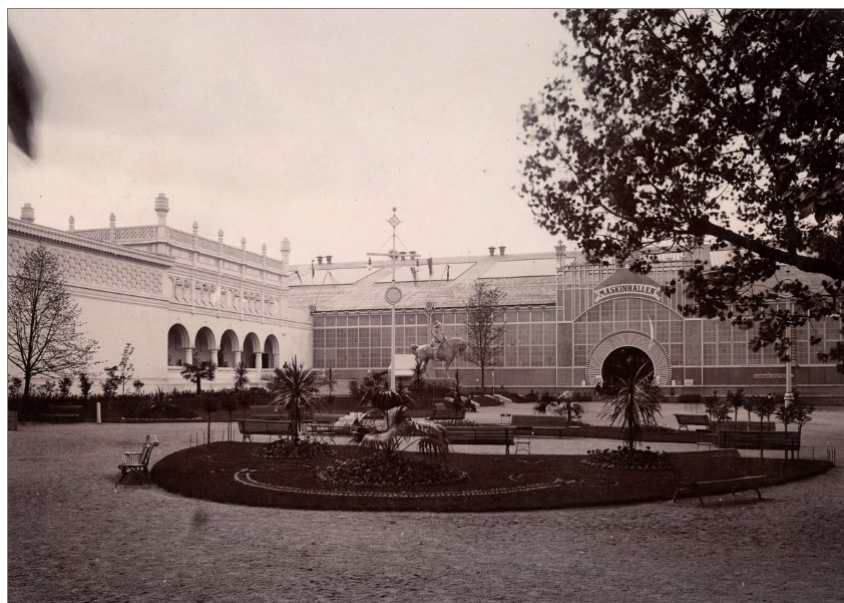
Maskinhallen från 1897 ritad av Ferdinand Boberg.
