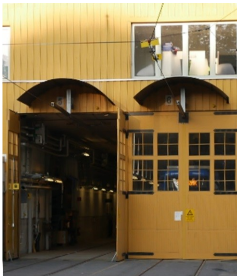
Befintlig fasad på Spårvagnshall mot Falkenbergsgatan
