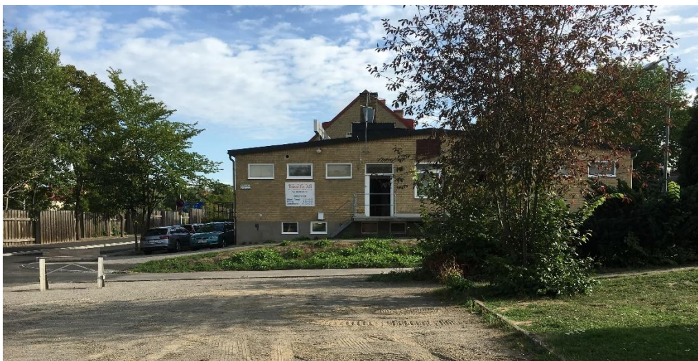
Figur 3.6 Foto tvätteribyggnaden på Vevstaken 29, i fotots framkant syns grusad yta och gräsmatta som tillhör Självstarten 22. Tvätteribyggnaden ligger topografiskt högre än Självstartaren 22.
