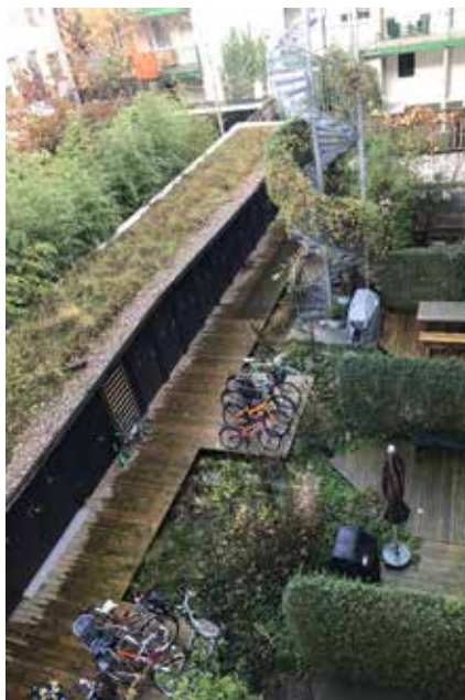
Trädäck med skelettjord under, på bostadsgård i Malmö
