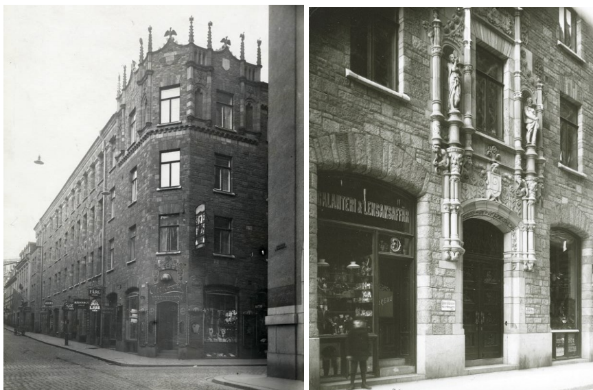
Till vänster: Korsningen Biblioteksgatan-Jakobsbergsgatan med hörnmotivets karaktärsgivande fialer längs takfotens krön. Till höger: Huvudentrén mot Biblioteksgatan, fotografi från tiden kring sekelskiftet 1900
