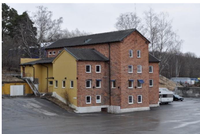
Den första sopförbränningsanläggningen från 1911 och som senare användes som kontor. Den västra gaveln i gul puts var hopbyggd med förbränningsugn och skyddsrum, vars byggnadsdelar revs 2006
