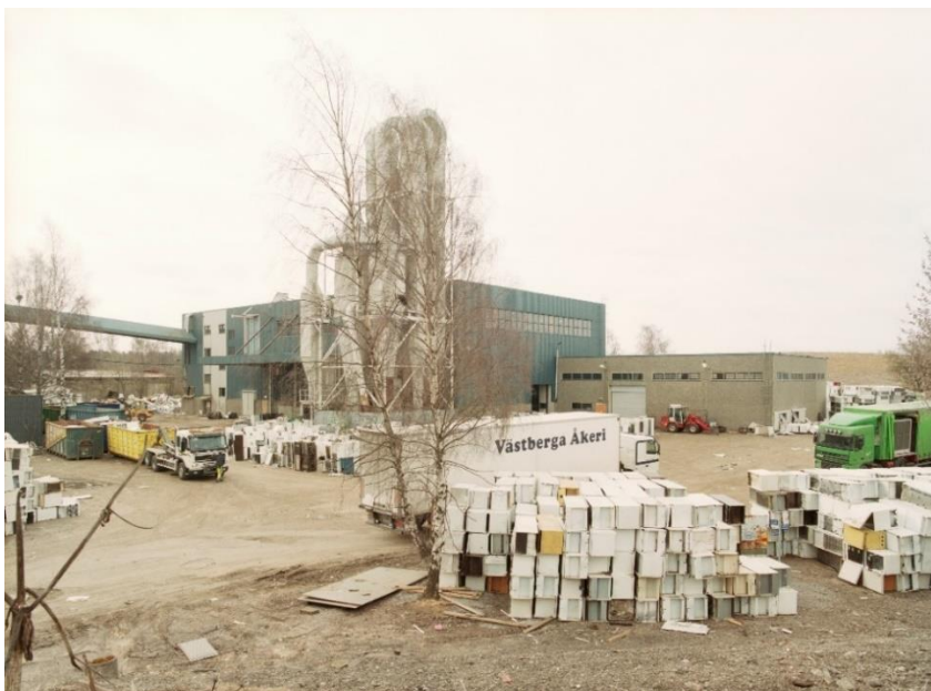
På 1970-talet uppfördes en försöksanläggning för automatisk sopsortering. Soporna kom från sopförbränningsanläggningen via transportbandet till vänster i bild. Senare användes anläggningen för att omhänderta kylskåp för återvinning, en funktion som byggnaden har även idag. Källa Tekniska museet. Fotograf Nisse Cronstrand. 2003.
