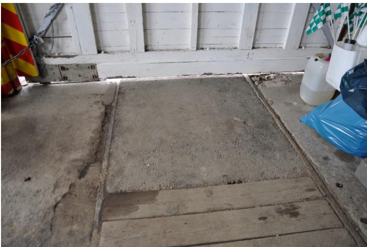
I den del som hyrs av golfklubben är byggnaden mindre förändrad interiört. Här syns tydligt spåren och en trälucka som troligen kunde lyftas vid service av tågen.
