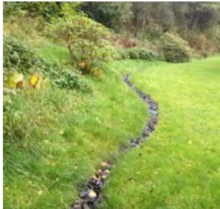
Figur 8 Exempel på avskärande dike i naturmarksslänt.
