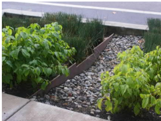
Figur 6 Exempel på växtbäddar för fördröjning och rening av dagvatten.
