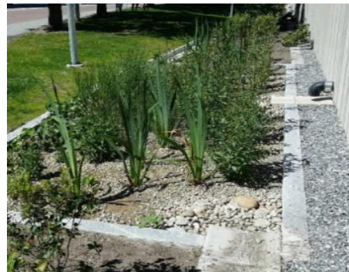
Figur 6 Exempel på växtbäddar för fördröjning och rening av dagvatten.
