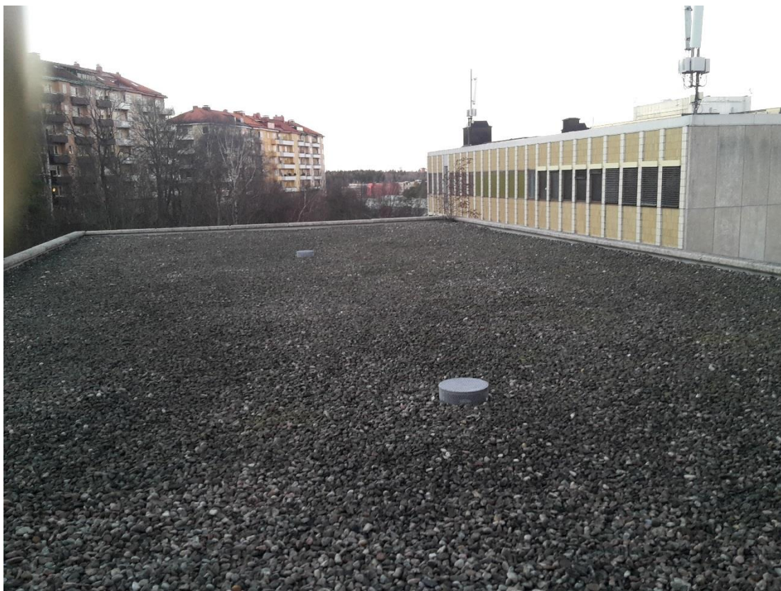
Figur 4: Brunnar på befintligt tak
