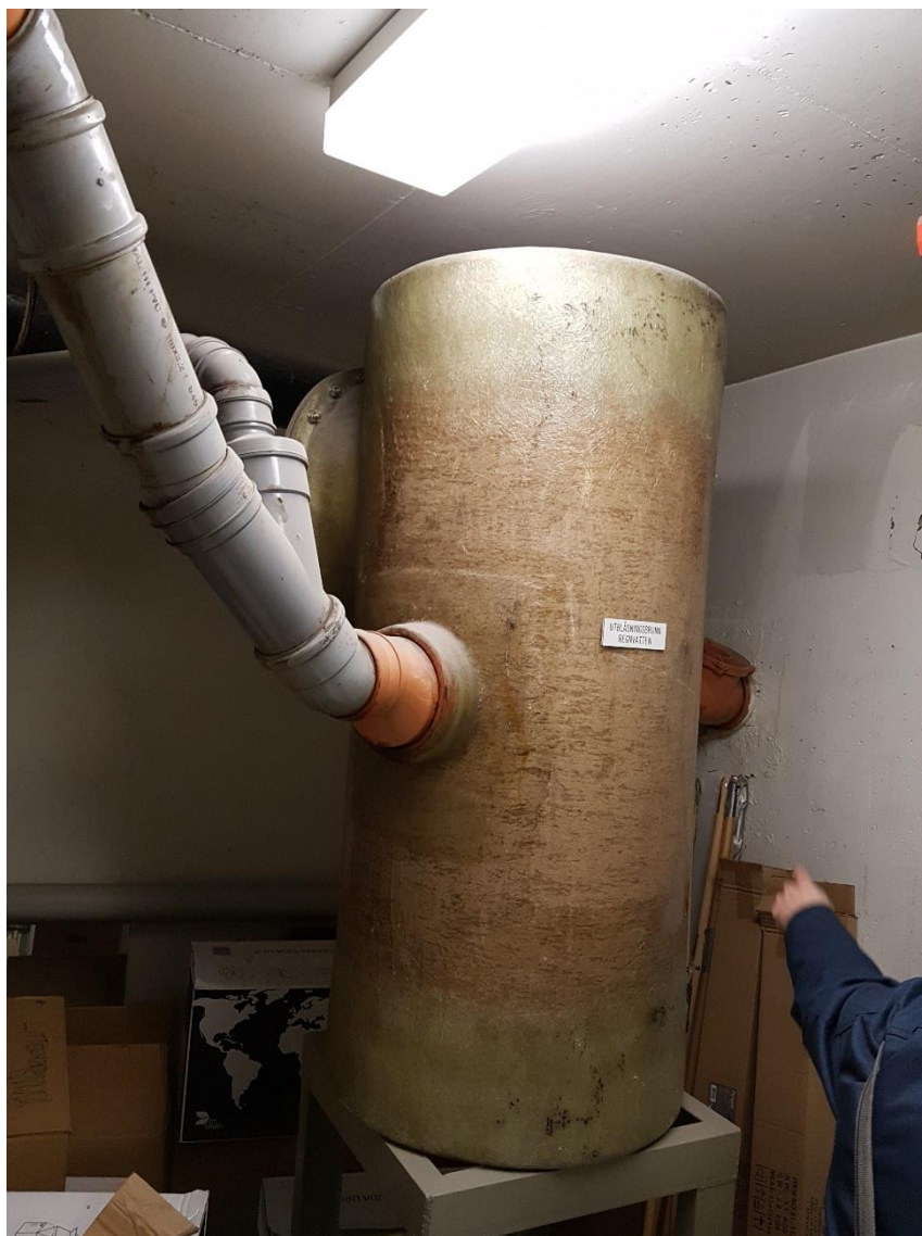
Figur 5: utblåsningsbrunn på plan 1 i garaget
