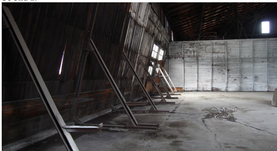
Bild 2. Stålbockarna som stöttar fasaden.
