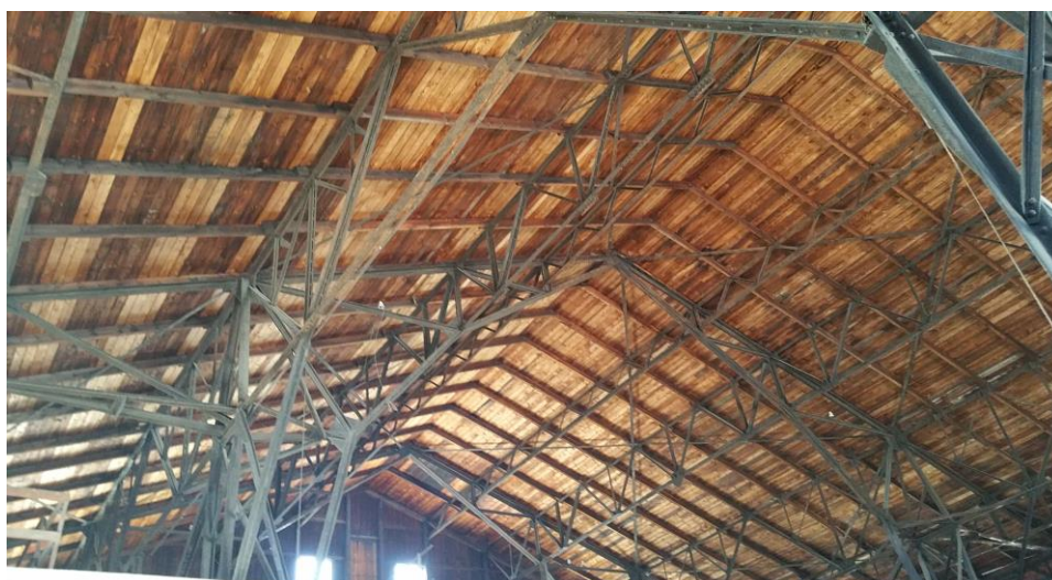
Bild 1. Fackverksramar och åsar. Även vindkryssen i tak skymtas.
