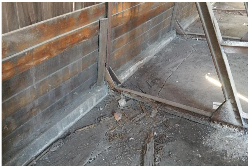
Bild 3. Betongplatta och eftergjuten sockel.
