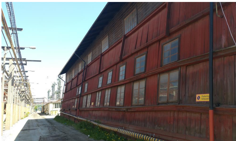
Bild 4. Bjälkarna på utsidan av sneda fasaden.
