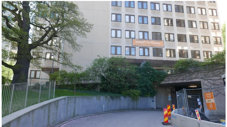
Figur 7. Vy norrifrån. Garageinfart under befintlig byggnad. Norconsult AB
