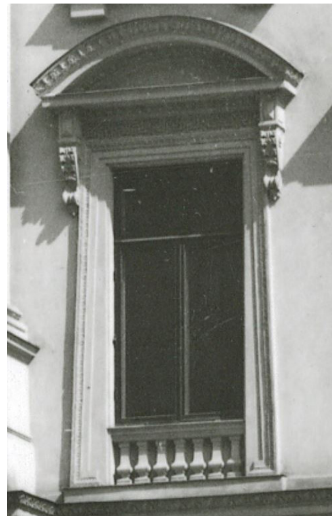
Fönstertyp på våning två. Omfattning av egyptisk form, reliefplatta med meanderbård, konsoler, välvt överstycke och blindbalustrad.
