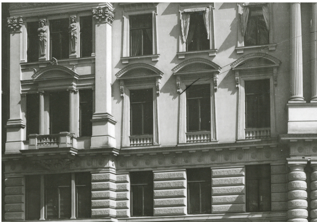
Kraftiga pistrar med korintiska kapitäl i byggnadens sidoraliter. Mellan våning ett och två tr. sträcker sig en dorisk bjälklagskant.
