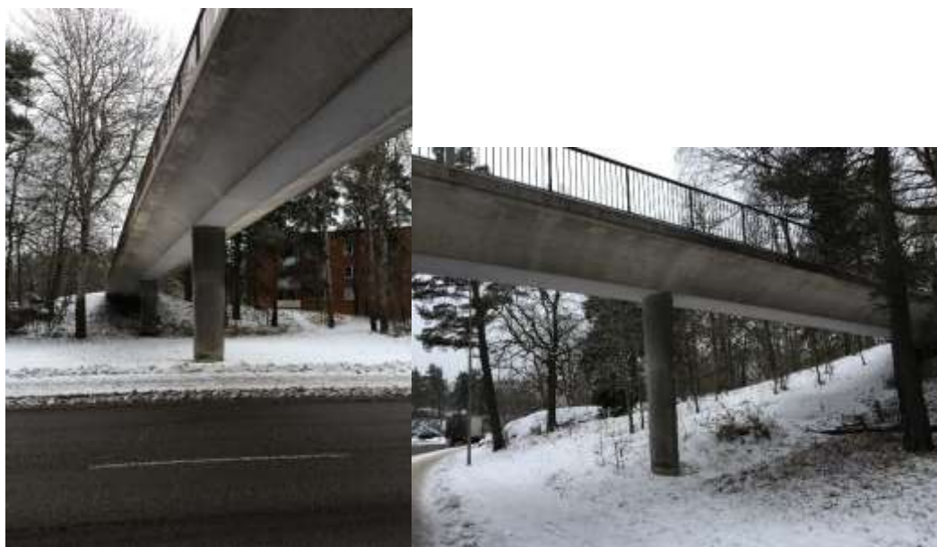
Figur 14. Bilder av bron vid Rosenstenen 2 tagna under platsbesöket.
