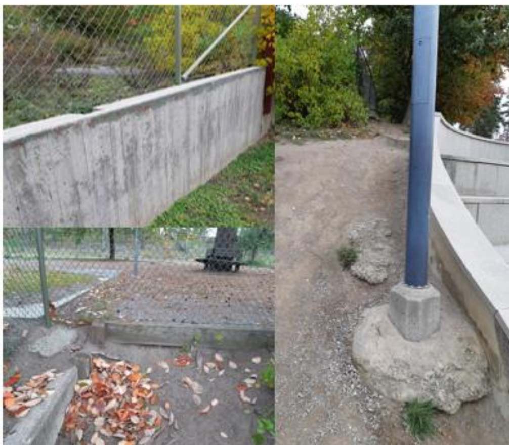
Figur 10 Fastighetsgränsen mot skolgården. Mur längst i väster, plankor och sluttning och längst till vänster stödmuren i södra hörnet på fastigheten. (bilder från platsbesök 20181011)
