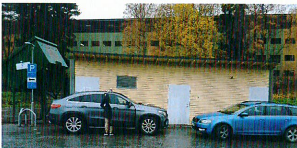
Figur 1 Byggnad där spillvattenpumparna är placerade
