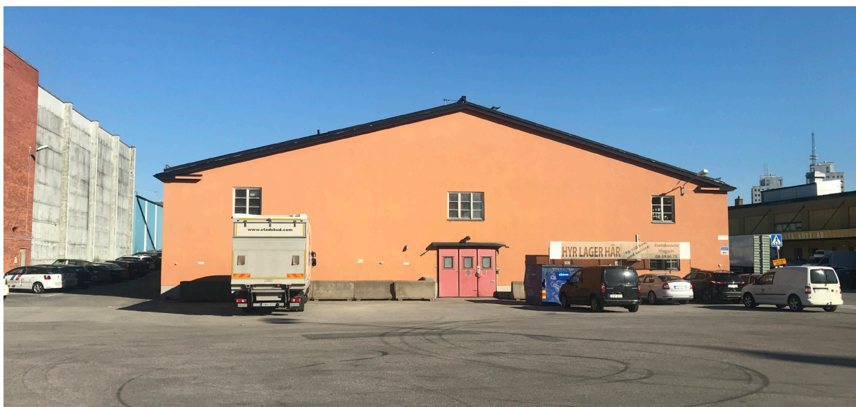
Byggnadens södra gavel.
