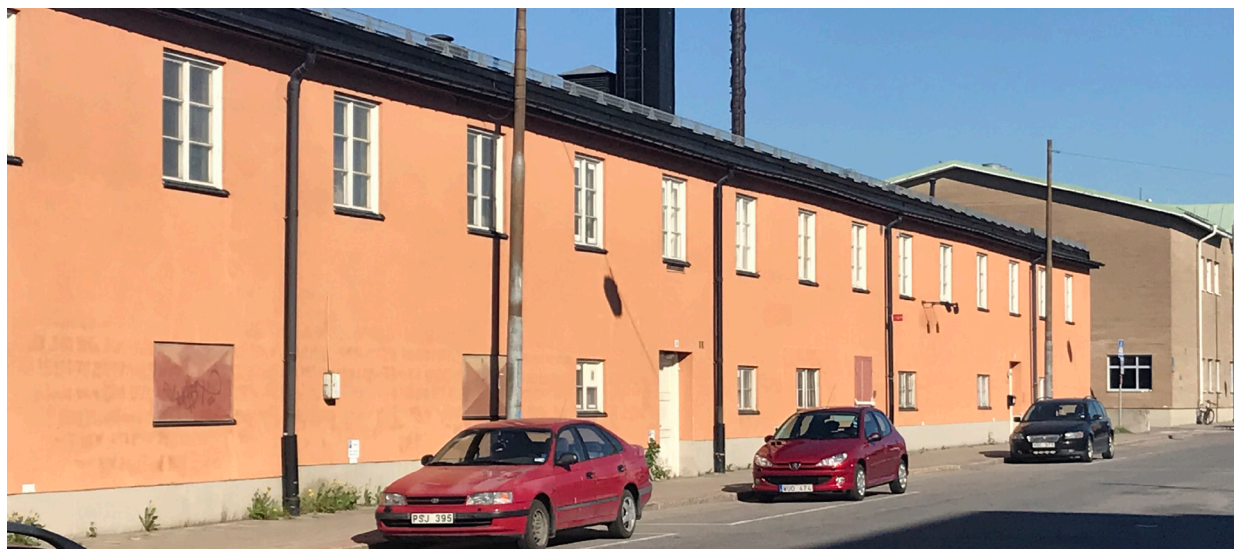
Byggnadens östra fasad.
