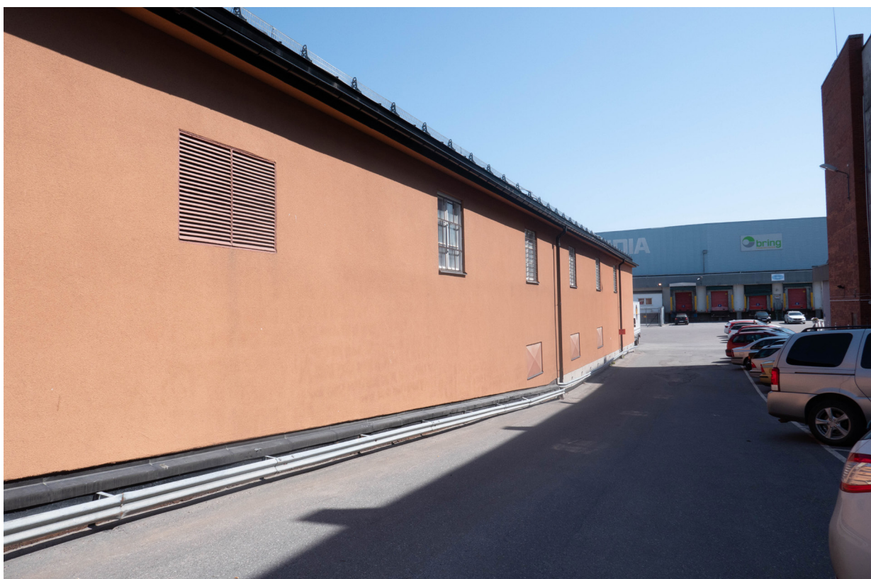
Byggnadens västra fasad.
