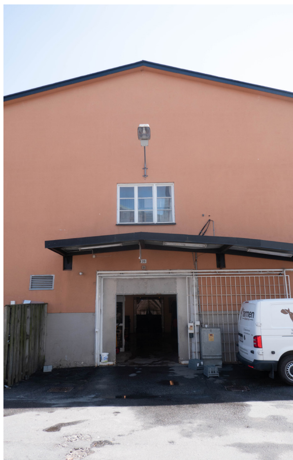
Byggnadens norra gavel.
