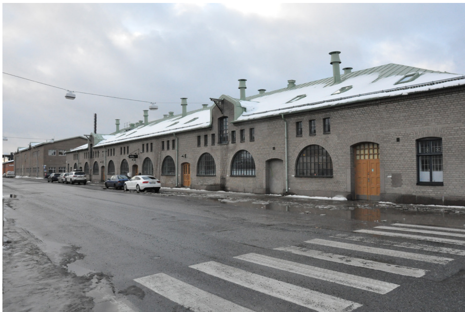
Hus 41 sett från Hallvägen, 2018.
