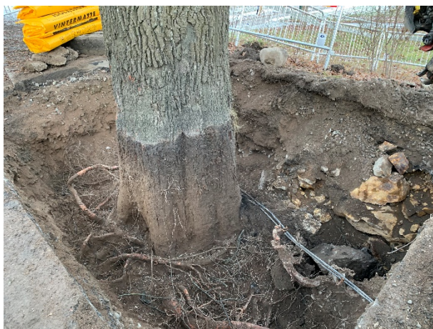
Bild 6 Oskadat rotsystem i den öppnade gropen
