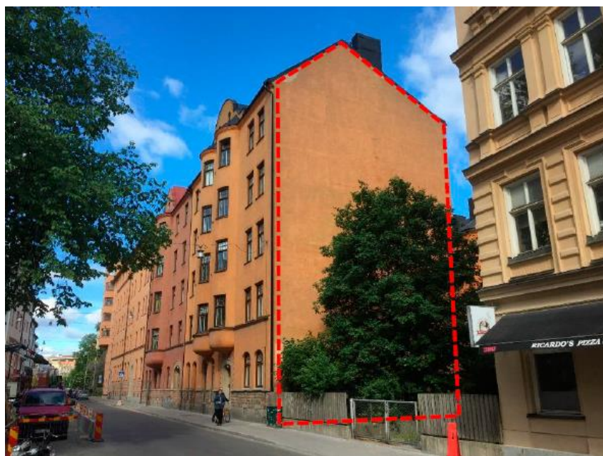
Brandgavel mot Bergsgruvan större 37 som byggs för.
