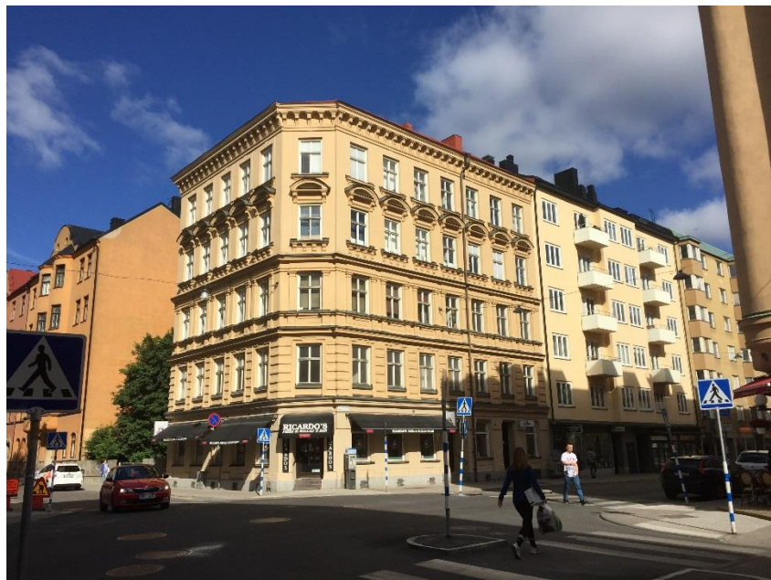
Befintlig hörnbyggnad på fastigheten. Vid trädet skymtar den obebyggda delen av fastigheten.
