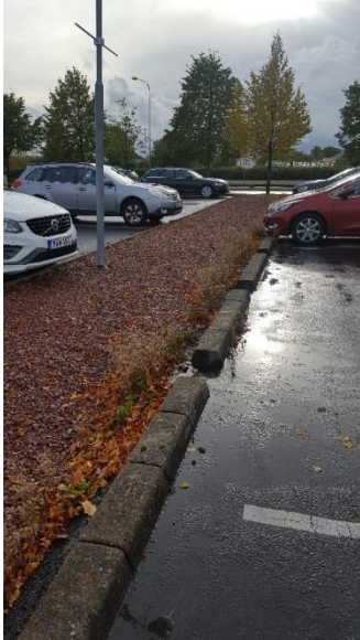
Figur 11 T.v. Möjlig utformning av makadamstråk i anslutning till parkeringsyta. Källa: Ramböll. T.h. Exempel på makadamdike mellan lokalgata och tomtmark. Källa: WRS (SVOA, u.d.).
