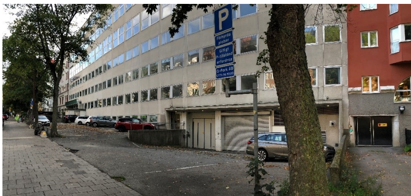
Figur 3. Förgårdsmarken mot Karlbergsvägen.
