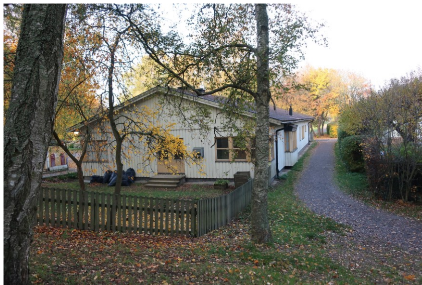
Befintlig förskolebyggnad som föreslås rivas.
