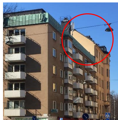
Brandgavel mot grannfastighetens Råttan 9 vid Torkel Knutssonsgatan.
