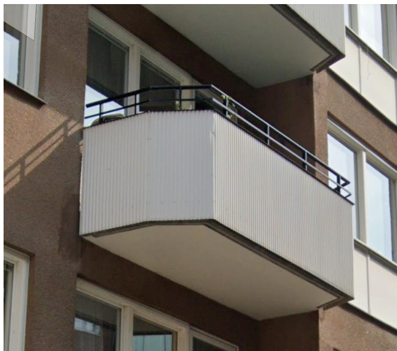
Balkongerna är utformade med heltäckande front och avfasade hörn. Undersidorna är målade i vit kulör.
