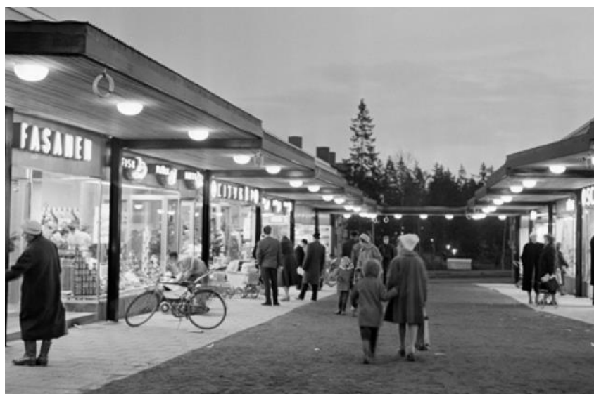
Högdalsgången tidigt 60-tal (Källa: SSM)
