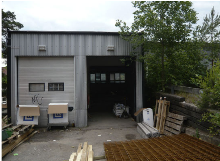
Tillbyggnad med lastkaj på östra fasaden.
