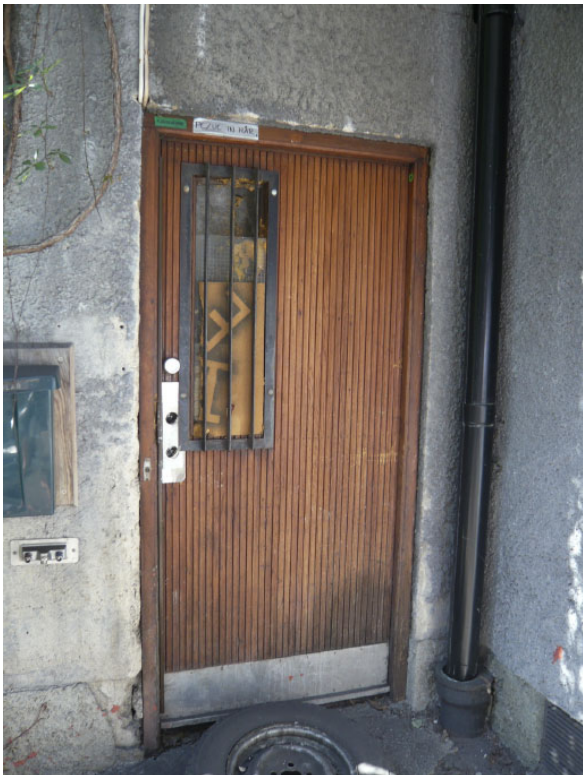
Dörrblad av lackad ek vid ingång till värmecentral mot sydväst.
