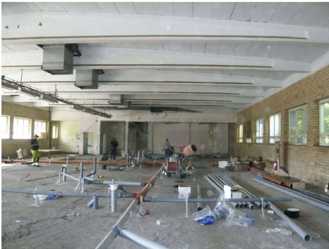
Tvätteridelens vån 2 tr har väggar av synligt gult fasadtegel och målat betongtak med synlig betongtakstol.
