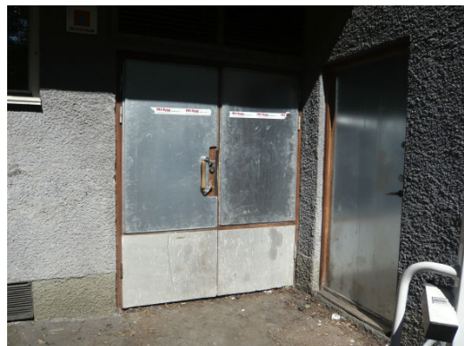
Ingång till byggnadens centrala trapphus från sydvästra fasaden. Dörrbladen har täckts med järnplåtar i senare skede.
