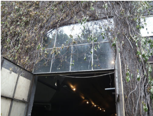
Värmecentralen bevarar ursprungliga fönster med smäckra järnprofiler.
