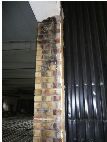
Tvätteridelen har ytterväggar av gult tegel.
