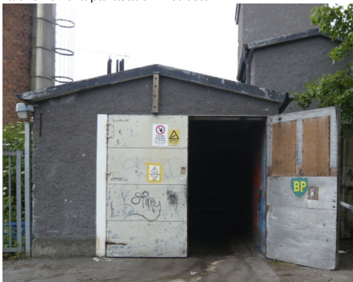
Lastintaget bevarar ursprungliga stålportar.
