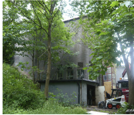
Värmecentralens fasad mot nordväst.
