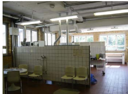
Tvätteridelens övriga våningsplan har golv belagt med klinkers och ytterväggar av synligt gult fasadtegel.
