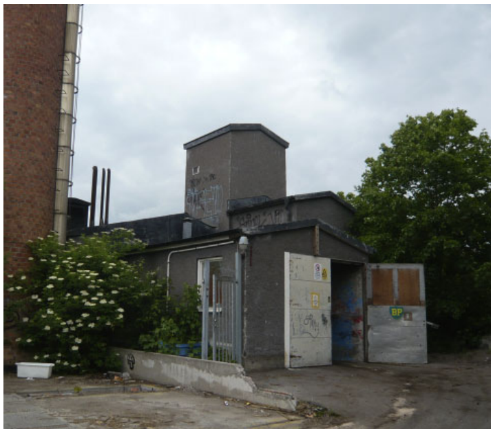
Tornliknande byggnadsvolym vid lastintaget till värmecentralens kolficka på fasaden mot öster.
