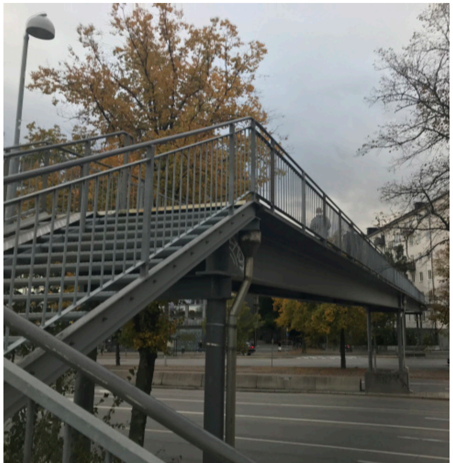
Bild: Befintlig gångbro över Sveavägen
