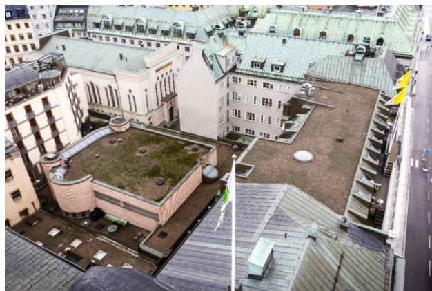
Vy från nord-ost över fastighetens taklandskap.
