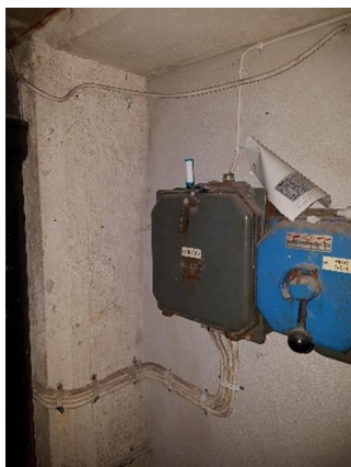
Figur 6. Provpunkt P302R i en pumpstation (205) i anslutning till parkeringsgaraget.
