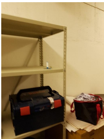
Figur 5. Provpunkt P300R i ett tekniskt utrymme (153) innanför undercentralen.
